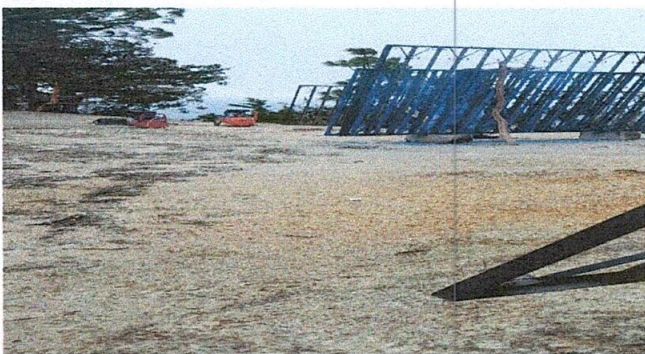
Foto 3: Sustitución de balcones
